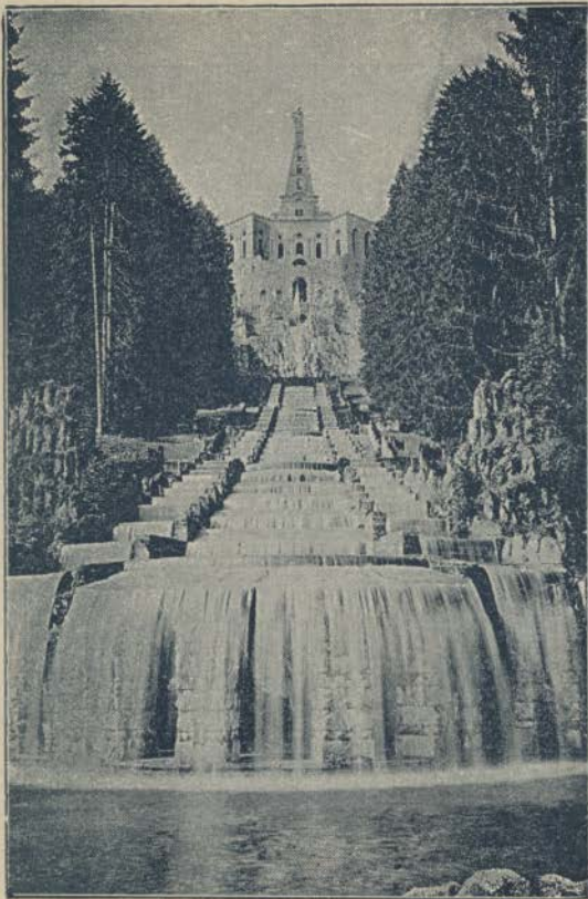
Der Herkules und die Kaskaden.
