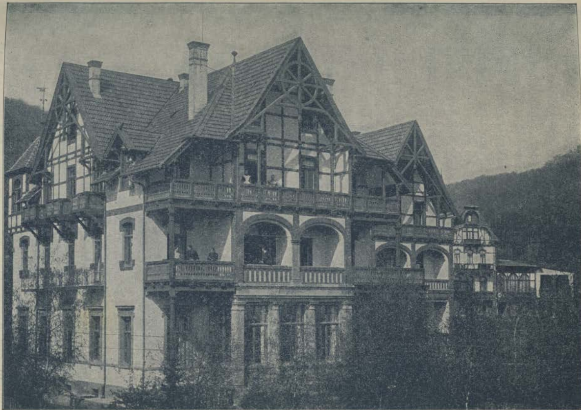
„Schweizerhaus“, (drittes Gebäude von Gossmann's Sanatorium).
